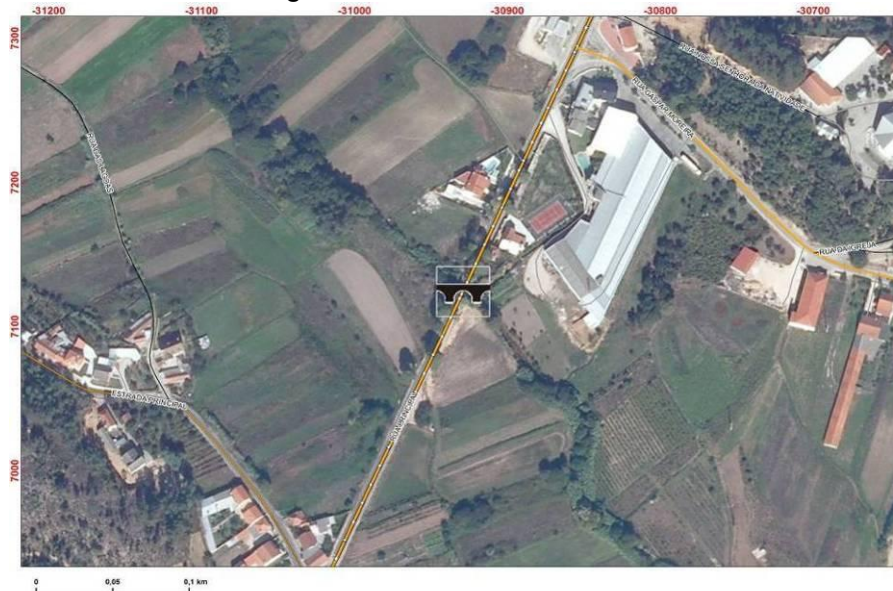
Figura 75: Ponte de Rio de Couros
