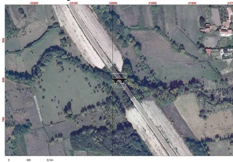
Figura 78: Ponte de Caminho de Ferro
